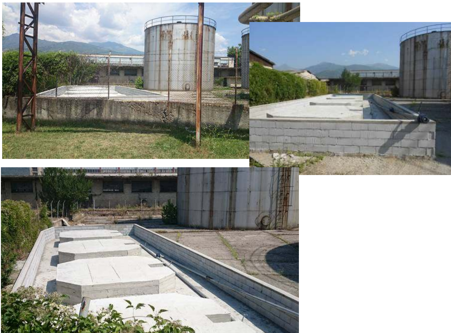
Слика 9-2 – Танквана за прифаќање на евентуални истекувања од надворешни резервоари за искористени масла во опфатот на инсталацијата за преработка на искористени масла
