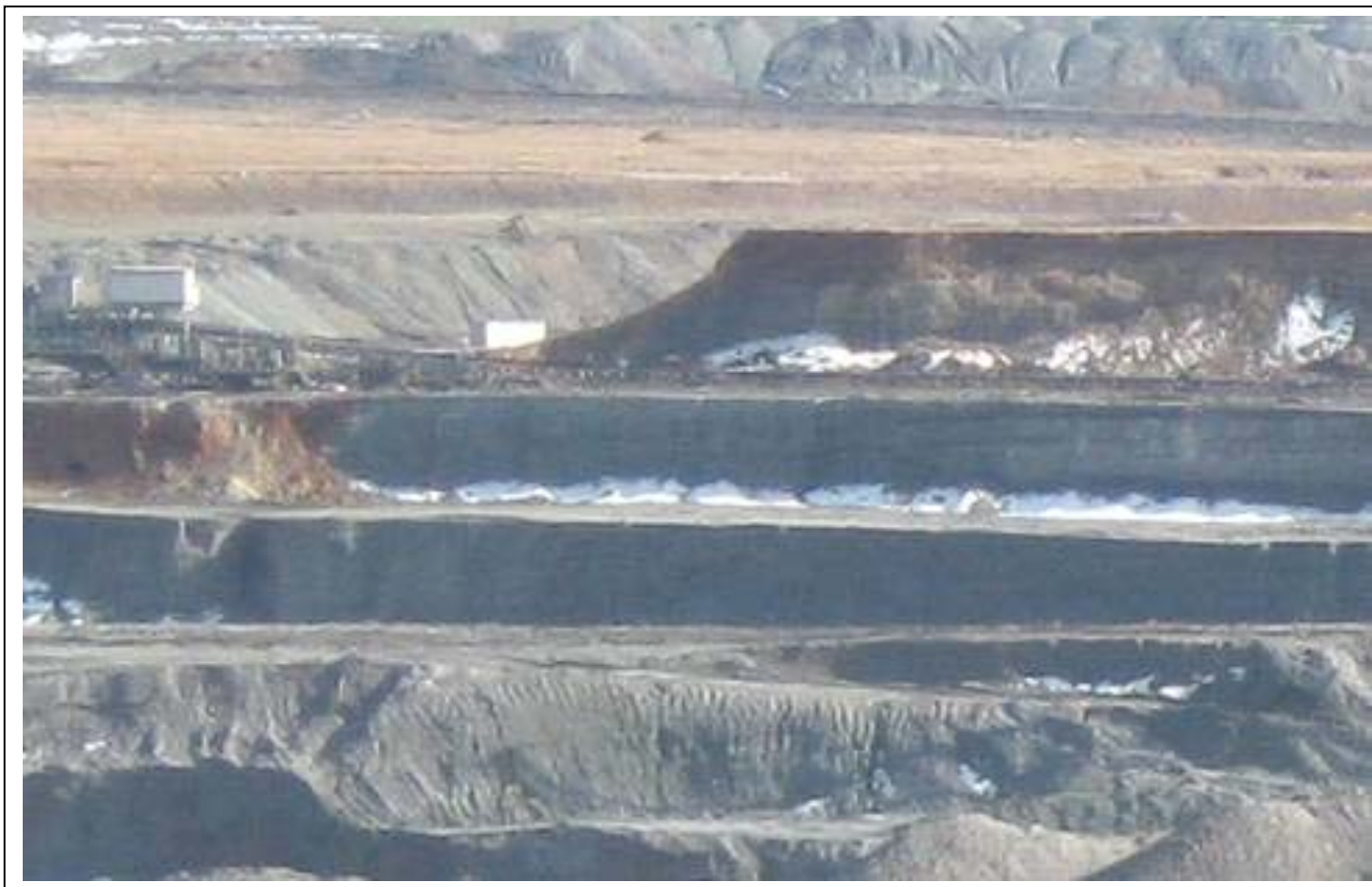
Слика бр.5: Етажен ископ на ПК „Осломеј-Запад“
