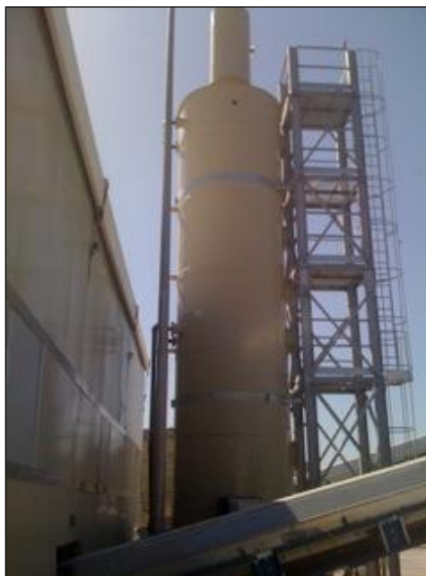
Слика 35: Изглед на предвидениот скрубер во постројката
